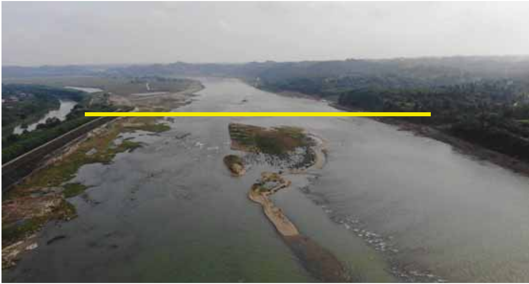
双江航电枢纽工程坝址
