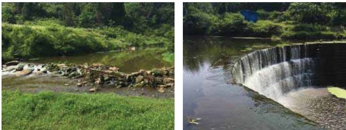
坛罐窑河拦河建筑较多
