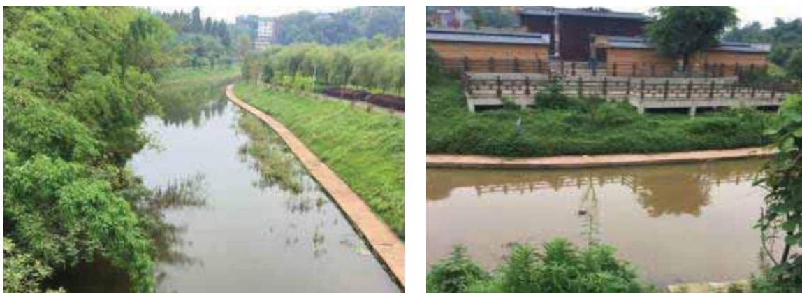
双江河河道渠化较为严重
