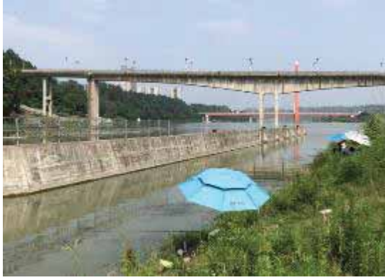
统计钩钓渔获物(三块石电站出水口处)
