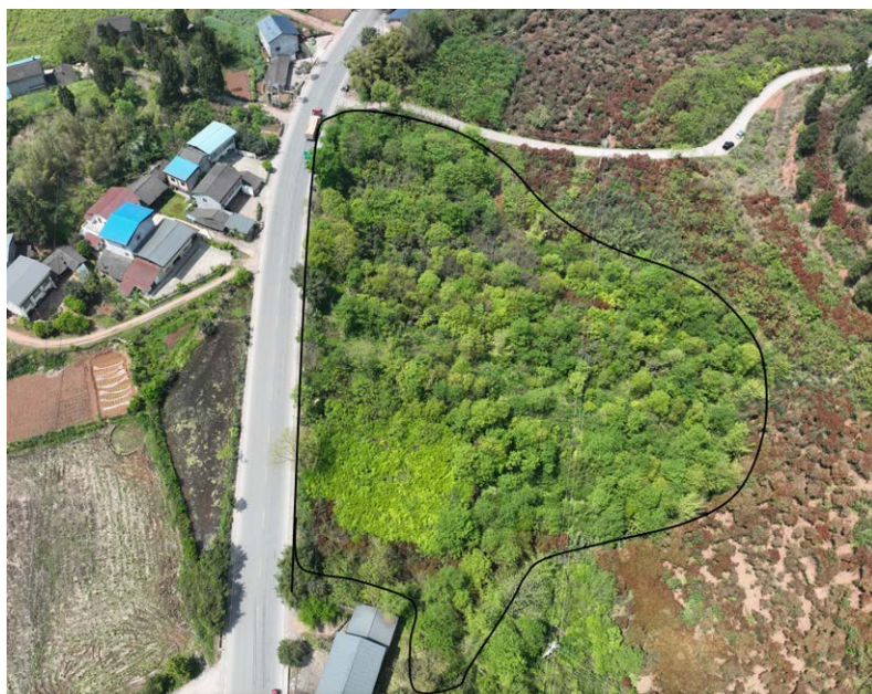
图5 塘坝镇农产品初加工及仓储基地建设项目项目现场图
