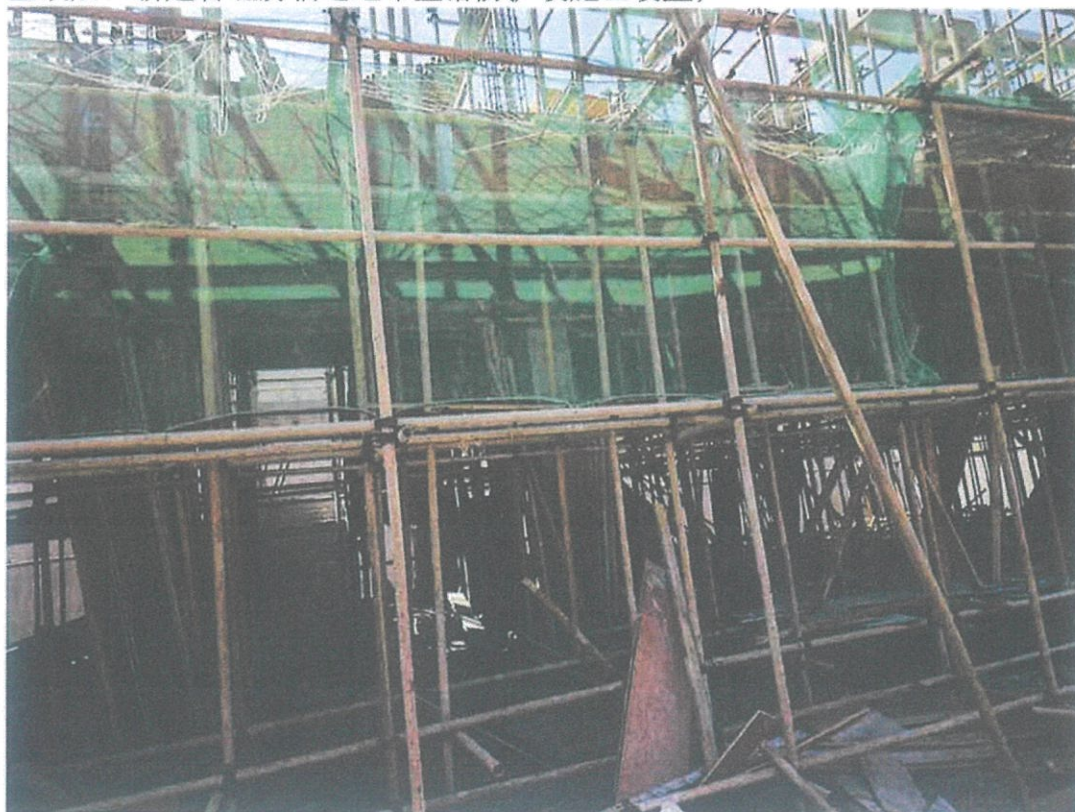
整改后：新建管理房临边地带坠落防护设施已设置；
