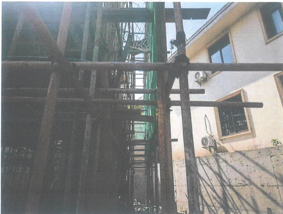
整改后：新建管理房临边地带坠落防护设施已设置；
