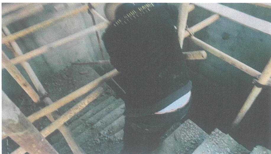
整改后：泵房楼梯段及泵房采取增设水平横杆防护
