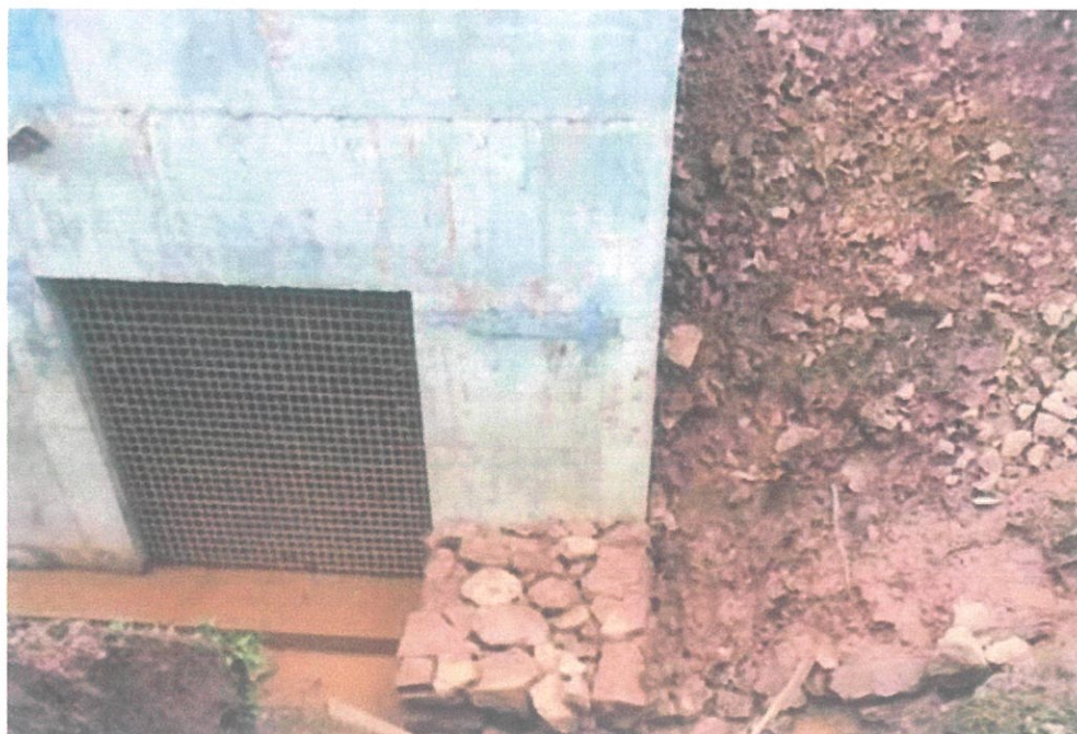
整改前：进水池顶部平台无临边防护。
