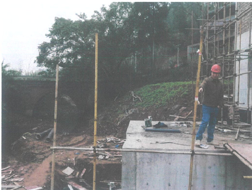
整改前：进水池顶部平台无临边防护。
