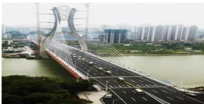
图 1-1 涪江大桥全景图
